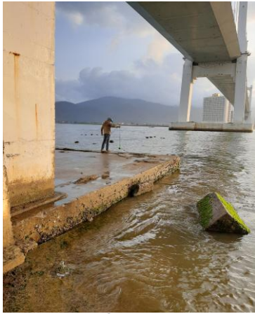
Hình 1. Cầu Thuận Phước
