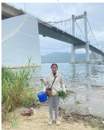
Hình 1. Cầu Thuận Phước
