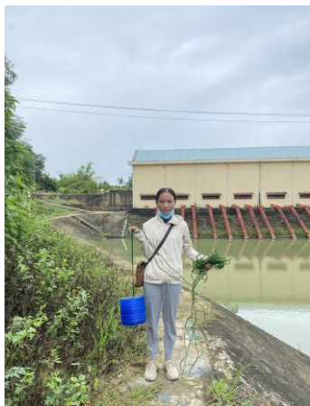
Hình 4. Trạm bơm Tír Câu
