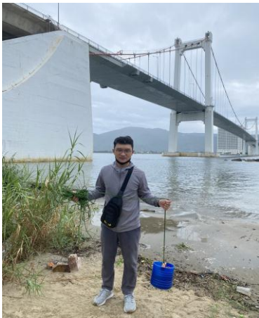
Hình 1. Cầu Thuận Phước
