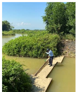
Hình 4: Trạm bơm Bích Bắc
