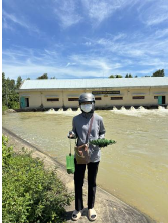
Hình 4. Trạm bơm Đông Quang
