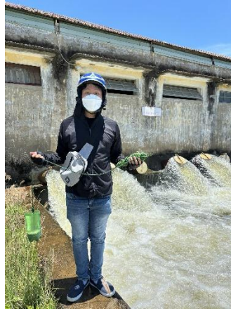
Hình 5. Trạm bơm Tư Câu
