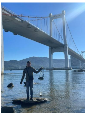
Hình 1. Cầu Thuận Phước
