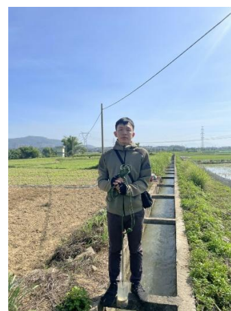
Hình 3. Trạm bơm Miếu Ông
