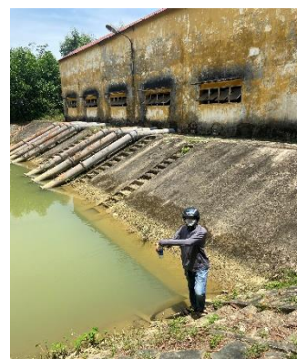
Hình 3: Trạm bơm Bích Bắc
