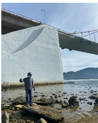
Hình 1: Cầu Thuận Phước
