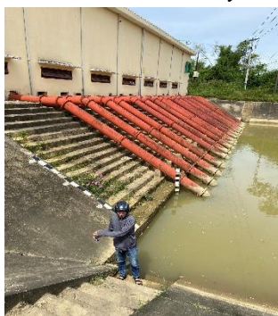
Hình 5: Trạm bơm Đông Quang
