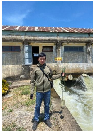
Hình 5. Trạm bơm Tứ Cầu
