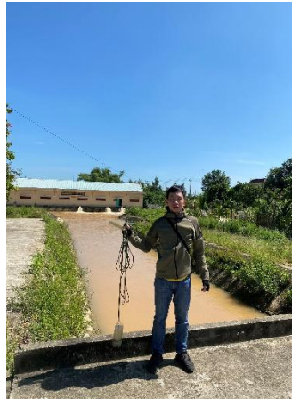
Hình 4. Trạm bơm Đông Quang
