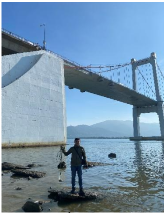
Hình 1. Cầu Thuận Phước
