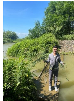
Hình 3. Trạm bơm Bích Bắc
