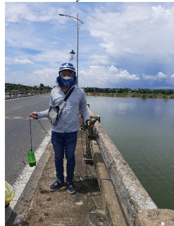
Hình 6. Cầu Câu Lâu
