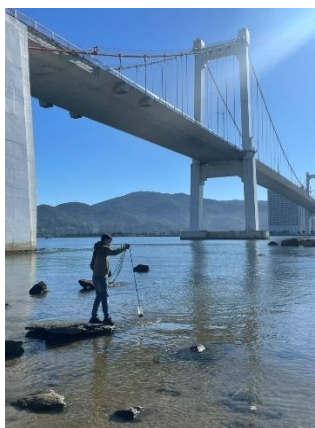
Hình 1. Cầu Thuận Phước
