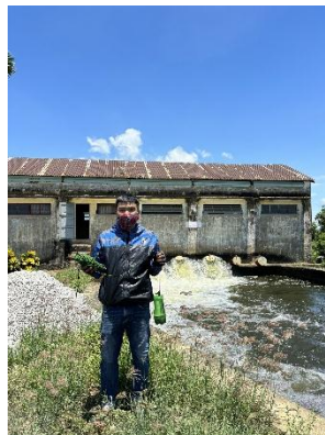
Hình 5. Trạm bơm Từ Cầu
