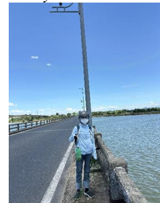
Hình 6. Cầu Câu Lâu
