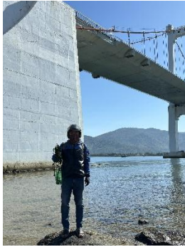
Hình 1. Cầu Thuận Phước
