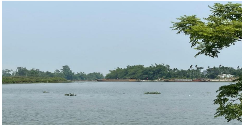
Hình 7. Công trình đập tạm Tứ Câu đã hoàn thiện
