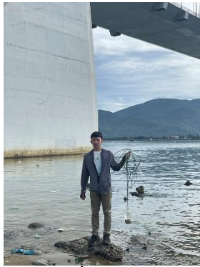
Hình 1. Cầu Thuận Phước
