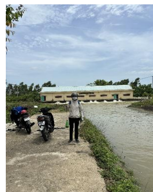
Hình 6. Trạm bơm Đông Quang
