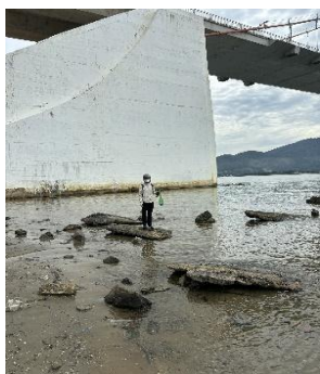
Hình 1. Chân Cầu Thuận Phước
