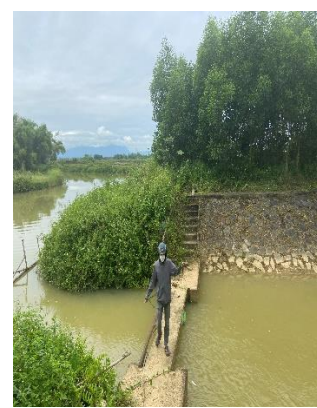
Hình 3: Trạm bơm Bích Bắc
