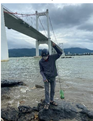
Hình 1: Cầu Thuận Phước
