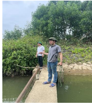
Hình 5. Trạm bơm Bích Bắc
