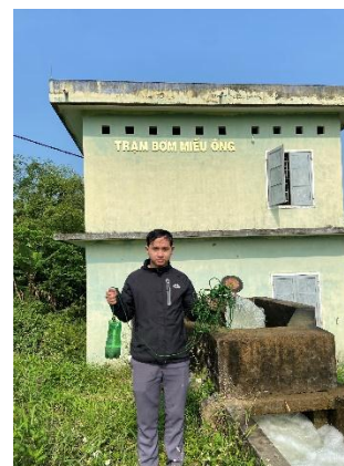
Hình 3. Trạm bơm Miếu Ông
