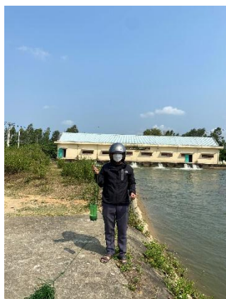
Hình 4. Trạm bơm Đông Quang
