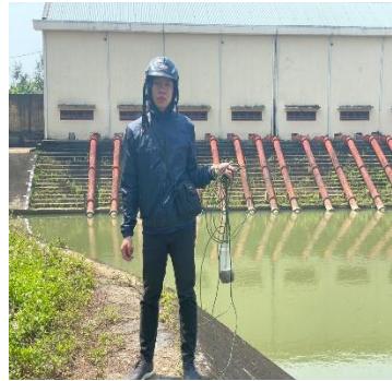
Hình 5. Trạm bơm Đông Quang
