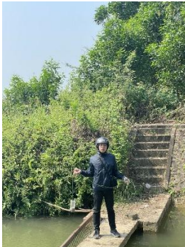
Hình 3. Trạm bơm Bích Bắc
