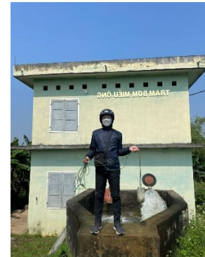
Hình 3. Trạm bơm Miêu Ông
