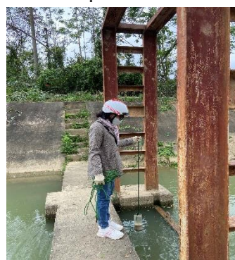
Hình 5: Trạm bơm Đông Quang
