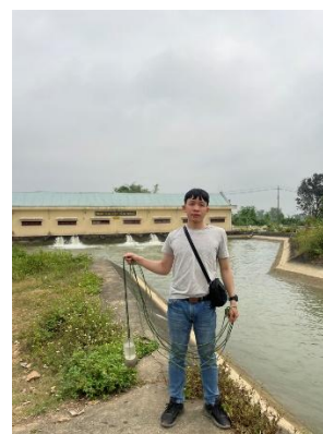
Hình 3. Trạm bơm Đông Quang
