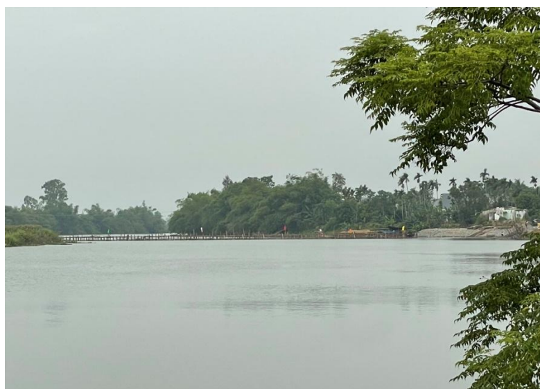
Hình 7. Công trình đập tạm Tứ Câu đang trong quá trình thi công xây dựng (Nguồn: Nhóm thực hiện)
