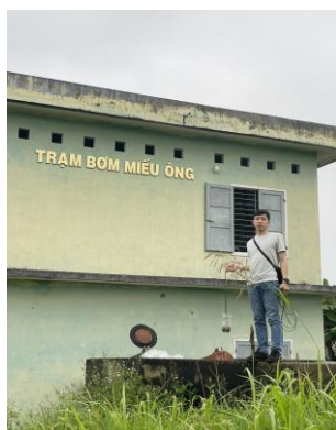
Hình 4. Trạm bơm Miếu Ông
