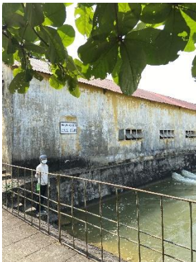
Hình 4. Trạm bơm Bích Bắc
