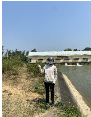
Hình 5. Trạm bơm Đông Quang
