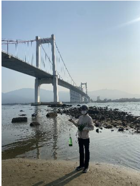
Hình 1. Cầu Thuận Phước
