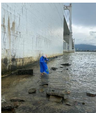
Hình 1: Cầu Thuận Phước
