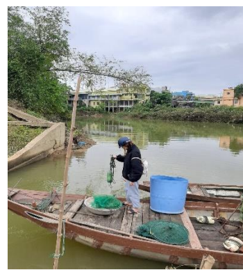
Hình 3: Trạm bơm Tuý Loan
