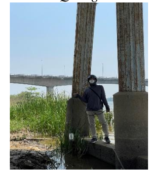
Hình 6: Cầu Câu Lâu
