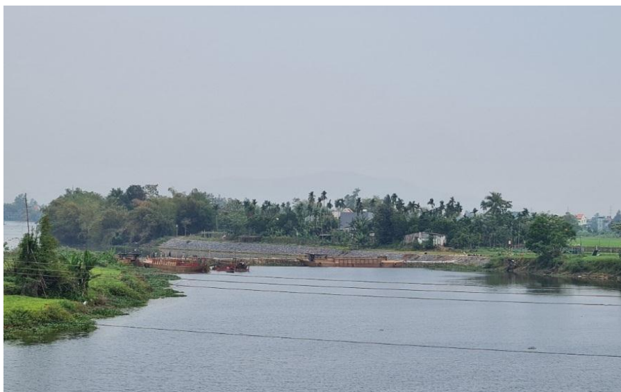
Hình 7. Công trình đập tạm Tứ Câu đã hoàn thiện
