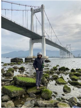
Hình 1. Cầu Thuận Phước
