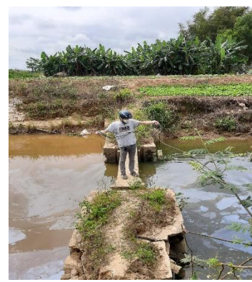
Hình 3: Trạm bơm Từ Cầu
