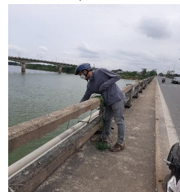
Hình 6: Cầu Câu Lâu
