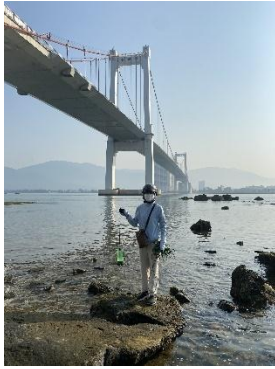
Hình 1. Cầu Thuận Phước
