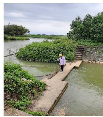
Hình 3: Trạm bơm Bích Bắc
