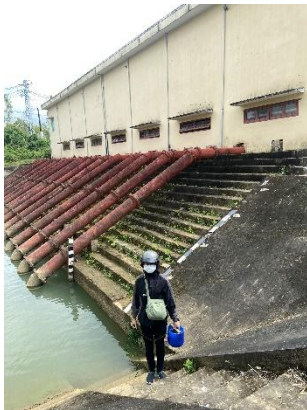
Hình 4. Trạm bơm Đông Quang
