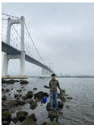
Hình 1. Cầu Thuận Phước
