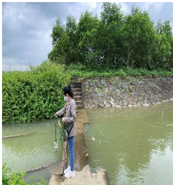
Hình 4: Trạm bơm Bích Bắc
