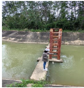
Hình 5: Trạm bơm Đông Quang
