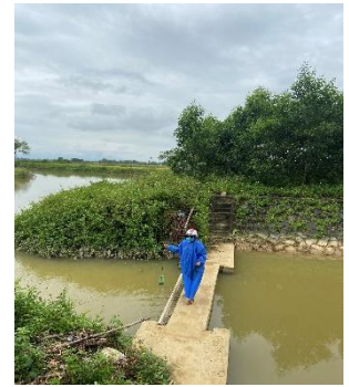
Hình 3: Trạm bơm Bích Bắc
