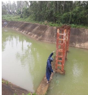
Hình 5: Trạm bơm Đông Quang
