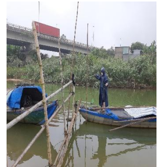
Hình 6: Cầu Câu Lâu
