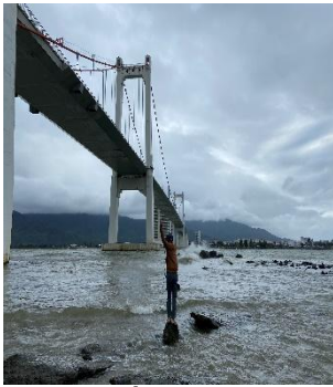
Hình 1: Cầu Thuận Phước
