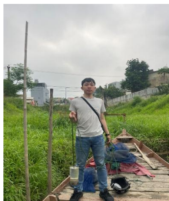
Hình 2. Trạm bơm Tuý Loan
