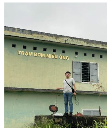
Hình 3. Trạm bơm Miếu Ông
