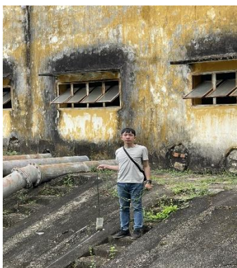
Hình 4. Trạm bơm Bích Bắc
