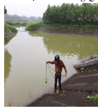
Hình 6: Trạm bơm Bích Bắc
