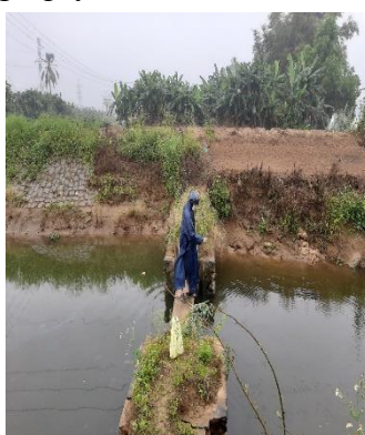
Hình 2: Trạm bơm Từ Cầu
