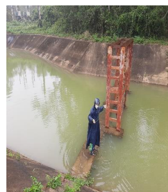
Hình 3: Trạm bơm Đông Quang
