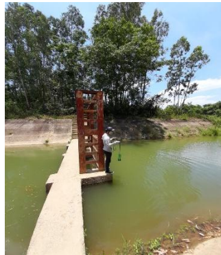
Hình 5: Trạm bơm Đông Quang
