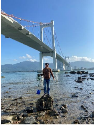
Hình 1. Cầu Thuận Phước
