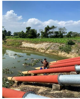
Hình 5. Trạm bơm Tư Câu
