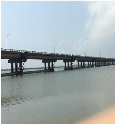
Hình 4. Đập Thảo Long mở cửa van vận hành xả nước
