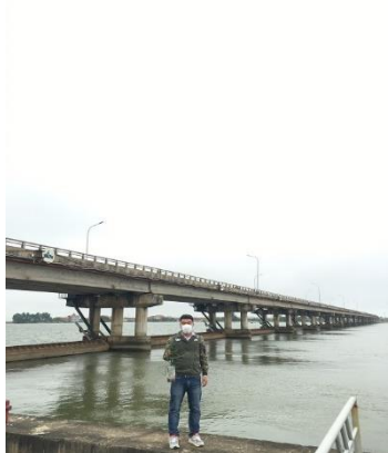
Hình 4. Đập Thảo Long
