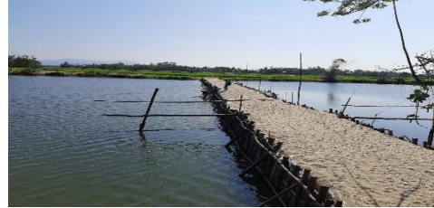
Hình 6. Đập tạm Tứ Câu
