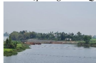
Hình 9. Đập tạm Tứ Câu
