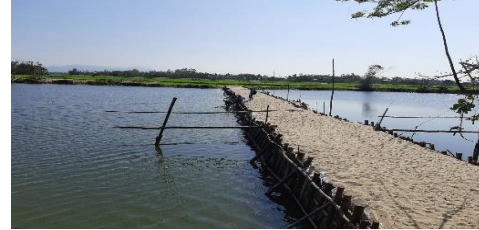
Hình 6. Đập tạm Tứ Câu
