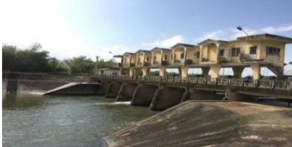
Hình 7. Đập dâng Bàu Nít
