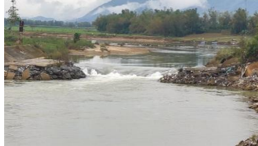
Hình 8. Đập tạm Quảng Huế
