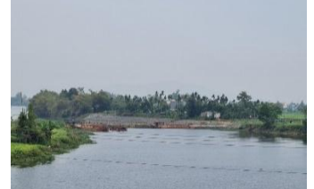
Hình 9. Đập tạm Tứ Câu
