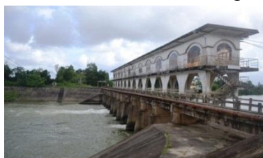
Hình 2. Đập dâng An Trạch
