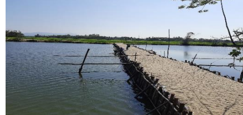
Hình 6. Đập tạm Tứ Cầu
