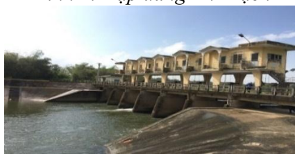
Hình 5. Đập dâng Bàu Nít
