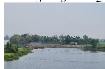
Hình 7. Đập tạm Tứ Câu
