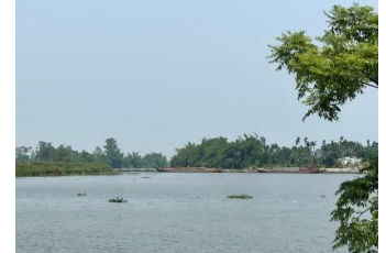
Hình 7. Đập tạm Tứ Câu
