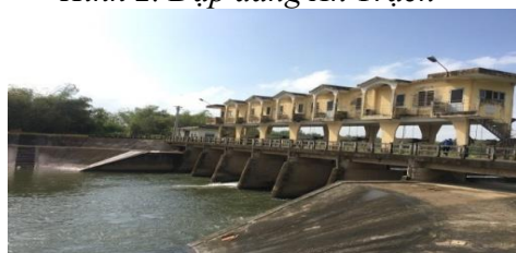
Hình 5. Đập dâng Bầu Nít
