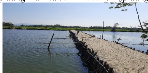
Hình 6. Đập tạm Tứ Câu
