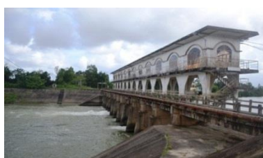
Hình 2. Đập dâng An Trạch
