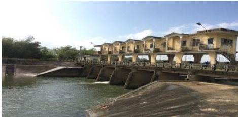
Hình 5. Đập dâng Bàu Nít
