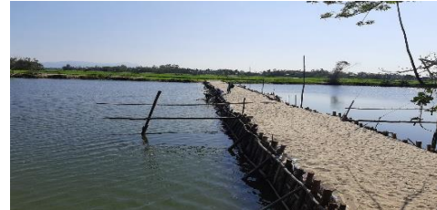
Hình 6. Đập tạm Tứ Câu
