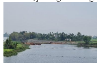
Hình 7. Đập tạm Tứ Câu
