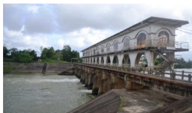
Hình 2. Đập dâng An Trạch
