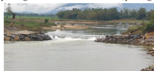
Hình 6. Đập tạm Quảng Huế
