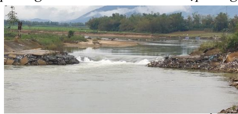
Hình 6. Đập tạm Quảng Huế
